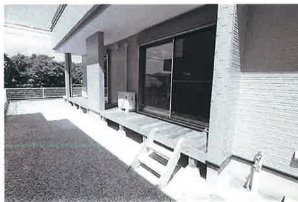
新設したウッドデッキ
